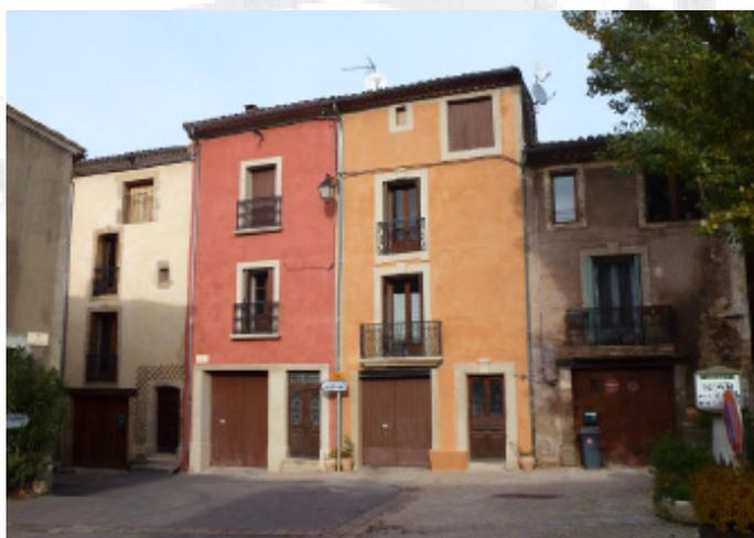
*Les enduits sont la peau de la façade. Ils protègent la maçonnerie des intempéries et favorisent l'évacuation de l'humidité présente dans les murs. Pour les constructions anciennes, il est impératif d'utiliser un mortier compatible avec la construction. La chaux naturelle, sa composition et sa mise en œuvre, garantissent la pérennité et la qualité de l'édifice. Par ailleurs, elle permet de réaliser des enduits plus lumineux.*
